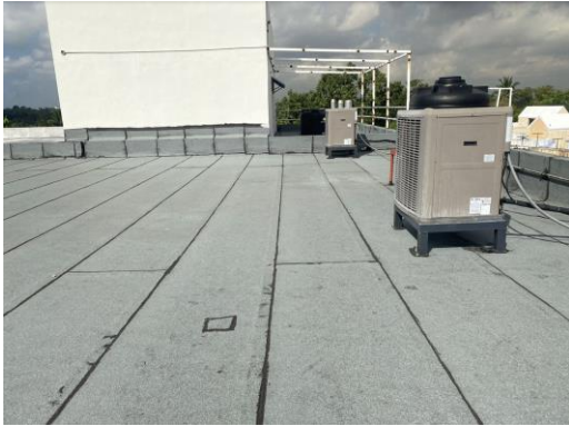
Sustitución Lona Asfáltica
