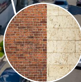
Fachada en ladrillo/coralina
