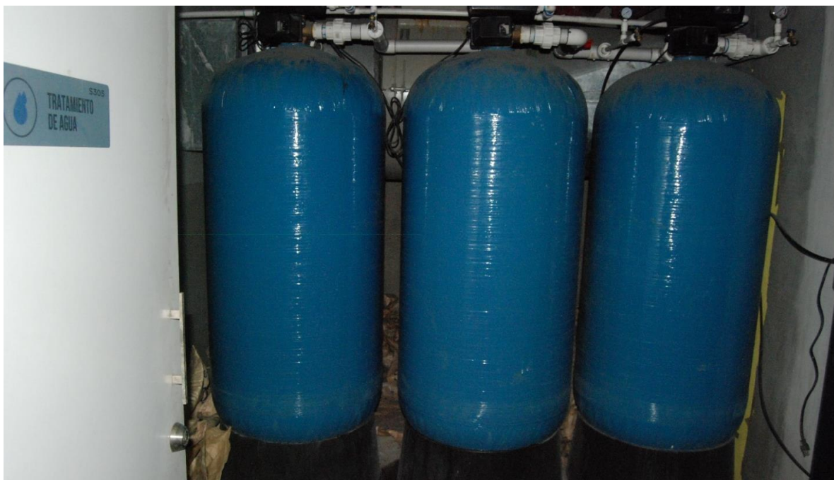
DESCRIPCIÓN DE LA PROPIEDAD. SISTEMA BOMBEO Y TRATAMIENTO DE AGUA GRUDA.
