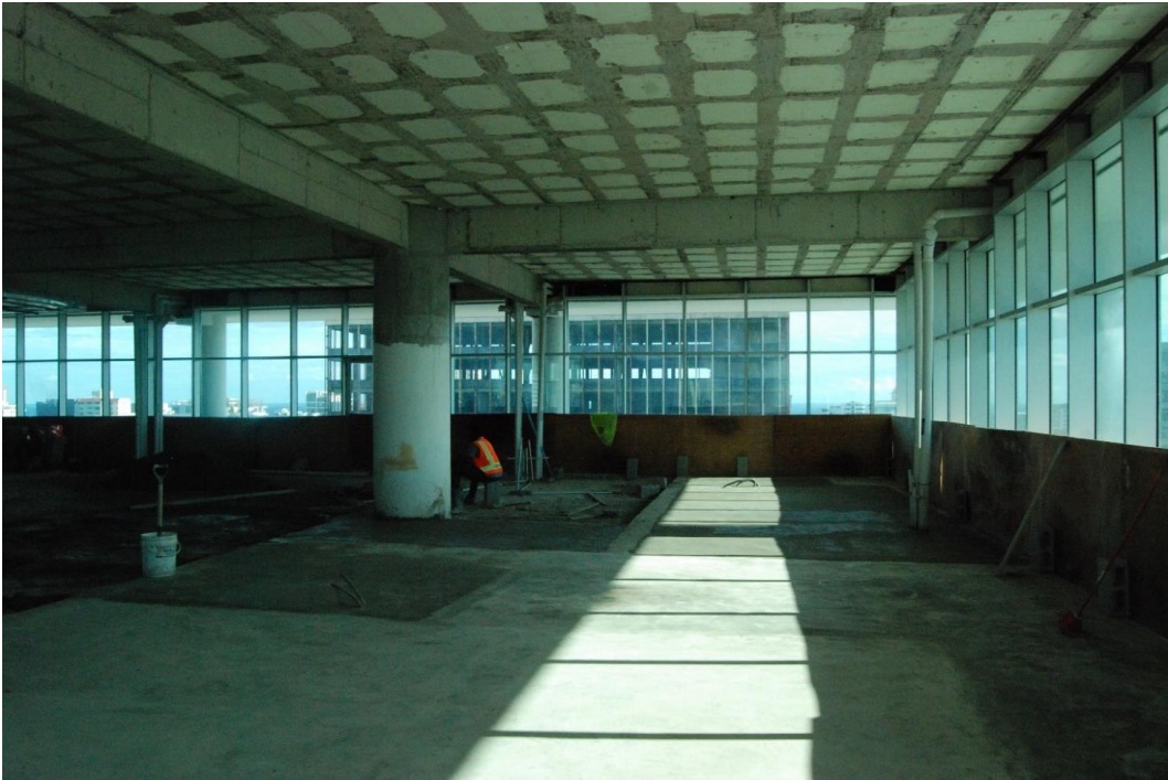
DESCRIPCIÓN DE LA PROPIEDAD. 4TO. NIVEL LOCAL No. 401.
