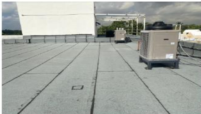
Sustitución Lona Asfáltica
