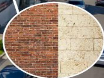
Fachada en ladrillo/coralina
